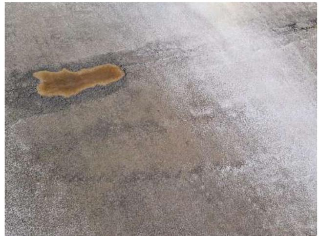
**Die Epoxidschicht ist abgerieben und Chloride dringen in den Beton ein**
