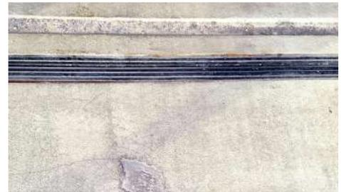
**Chloridschäden - Beschichtung löst sich durch Abrieb**
