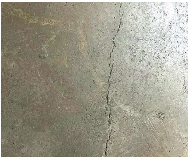
Rissbildung - Beton ist ungeschützt
