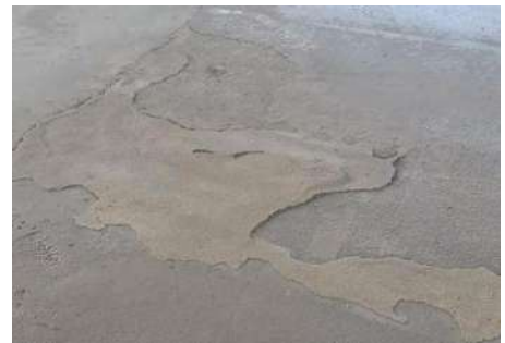
Bandage - Schäden verdeckt. Beton unter der Beschichtung ungeschützt
