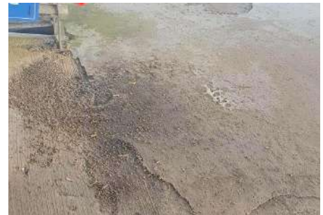
Bandage - Schäden verdeckt. Beton unter der Beschichtung ungeschützt
