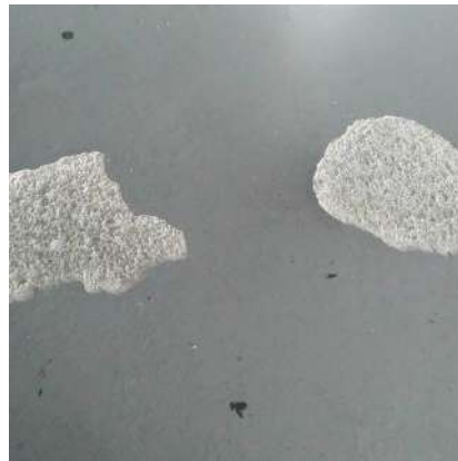
Abb.: Übliche Abriebschäden
