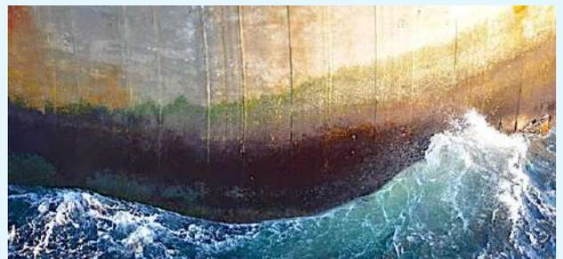
Das Bild zeigt den Beton nach Jahrzehnten im Meerwasser. Anforderung an den Betonschutz: Versiegeln vor Chloride, Öl und Salzen.
