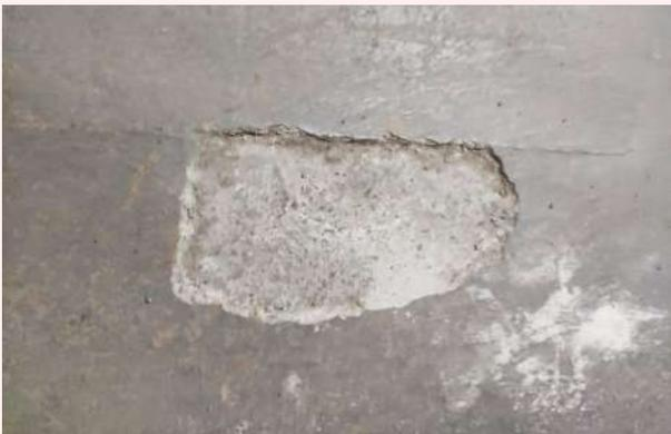
Die oben abgebildeten Fotos zeigen den freigelegten Betonboden. Durch Abrieb wird die Beschichtung entfernt. Betonböden von Garagen, Parkhäusern und Industriehallen verlieren ihren Schutz.
