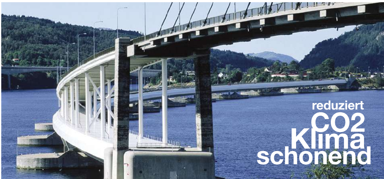
Brücke steht seit Jahrzehnten in Westnorwegen und ist extremsten Wetterbedingungen ausgesetzt (Arktisches Klima). Regelmäßige Inspektionen zeigen keine entstandenen Mikrorisse und Angriffe auf den Beton. Der Chlorid-Schutz ist absolut gesichert.
