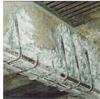
Betonschäden und die darauf resultierende Zerstörung. komsol® Ingenieure bieten eine schnelle und permante Lösung.
