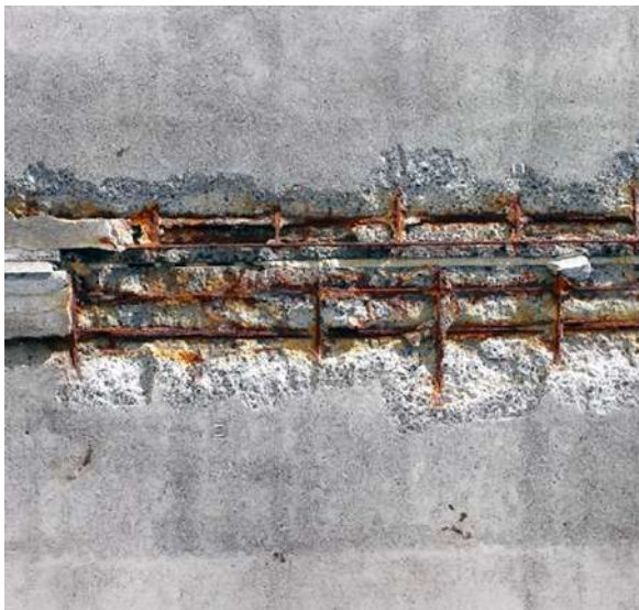
Beschichtung löst sich durch Kondensbildung und bricht auf. Jetzt ist der Beton ungeschützt.
