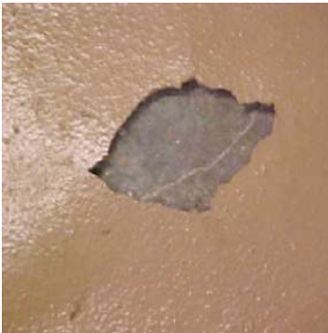
Beschichtung löst sich durch Kondensbildung und bricht auf. Jetzt ist der Beton ungeschützt.
