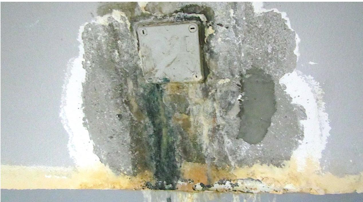
Chlorid Problem: **komsol®** empfiehlt Betonexperten hinzuzuziehen, um mit einer Zustandsanalyse zu beginnen. An verschiedenen Stellen muss der aktuelle Chloridgehalt festgestellt werden.
