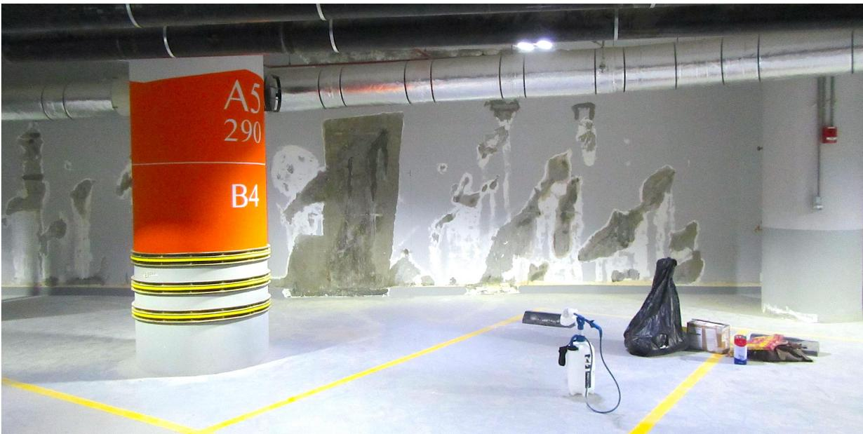
Zunächst werden Betonflächen auf Hohlräume untersucht, da durch solche Undichtigkeiten Wasser mit den darin gelösten Salzen eindringen können (Leckage). Für solche Undichtigkeiten gibt es drei Hauptursachen:
