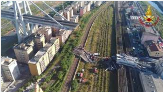
Puente en Génova (Italia)
