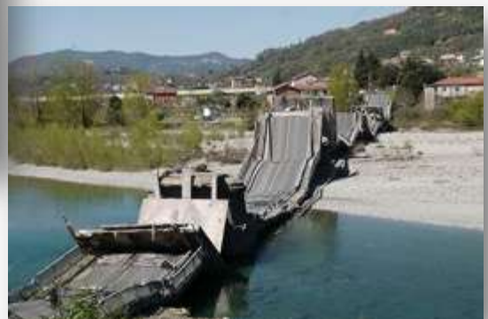
Puente sobre el Río Magra (Italia)
